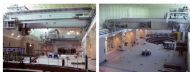
Рис.15, 16 Машинный зал Бурейской ГЭС
